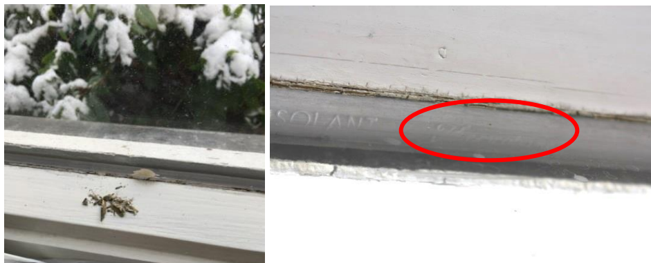
Figur 2.3: Vinduer med asbestholdig kitt. Bildet tatt i møte-rom ved vestibylen, 1. etg. I Midtbygg
