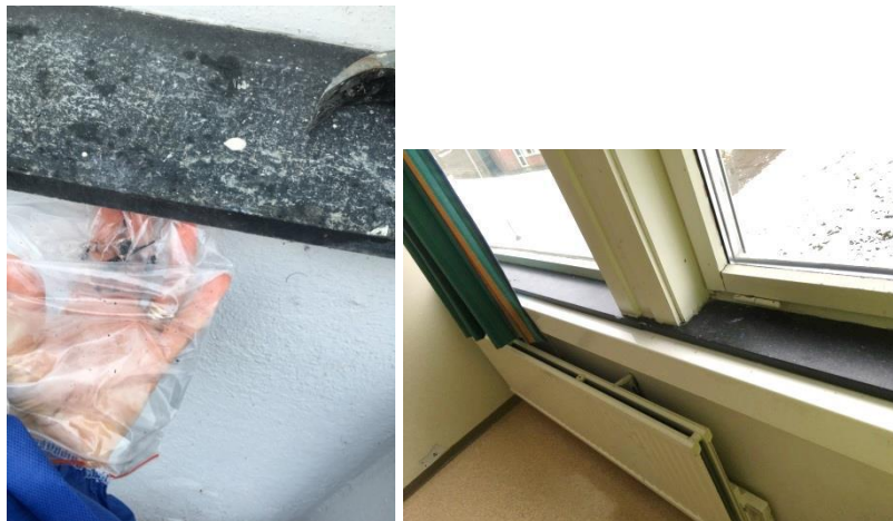
Figur 2.6: Asbestholdige vindusbrett
