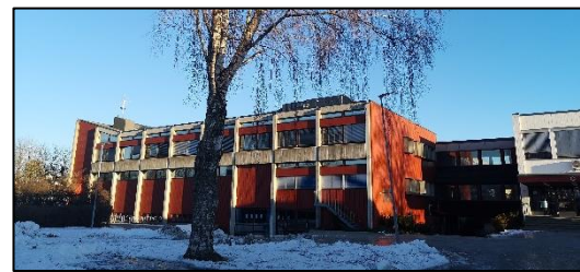
Eksisterende bygg B
