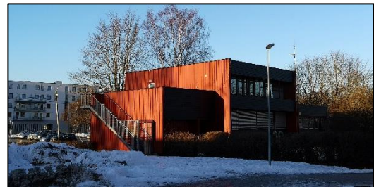
Eksisterende bygg E (skal rives)
