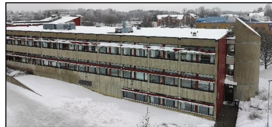
Eksisterende bygg A (skal rives)
