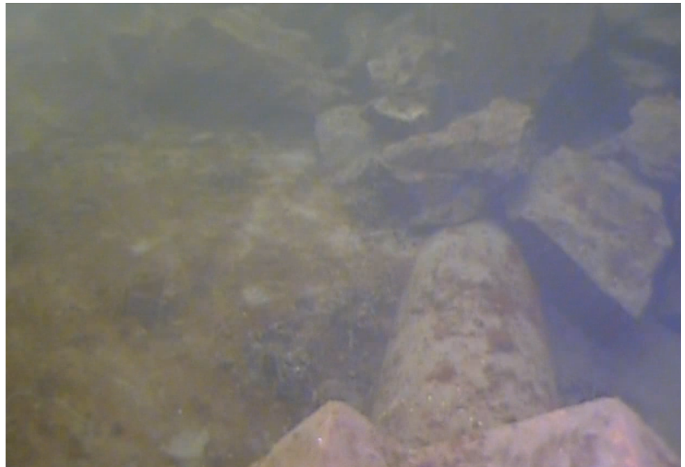
Figur 7 viser rør som går inn i steinfylling. Store blokker ligger direkte på røret.
