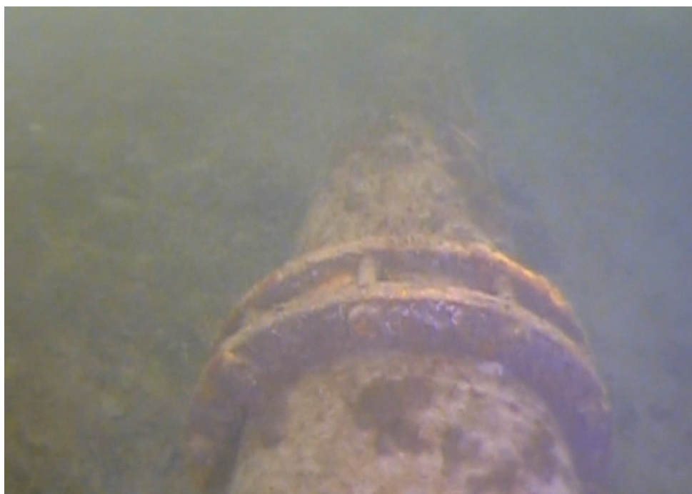
Figur 6 viser flenseskjøt rett før røret går inn i steinfylling.
