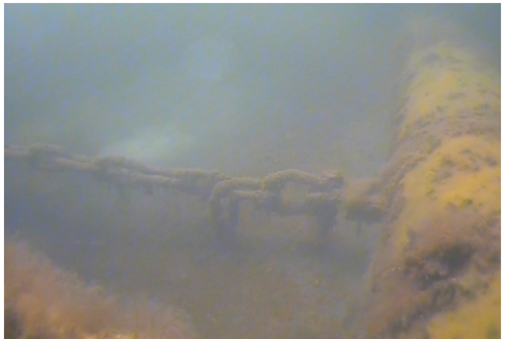
Figur 4 viser sikring av rør med klammer og kjetting.
